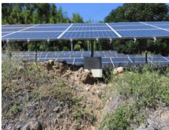
基礎が露出し浮いている太陽光発電設備
