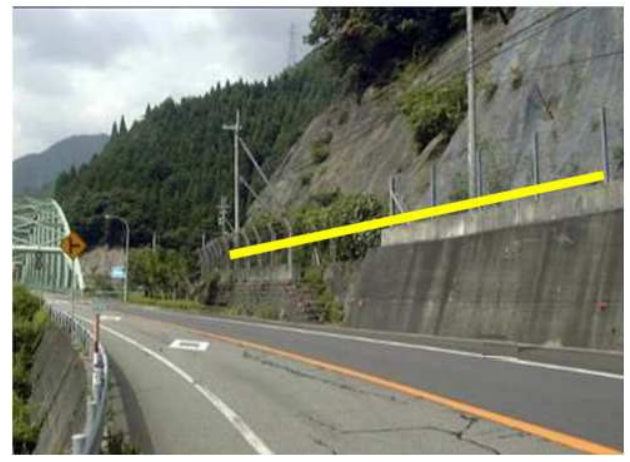
山地の道路沿いの擁壁上部
