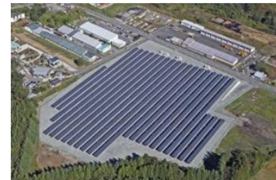
【設備イメージ（出力1,900kW）】
