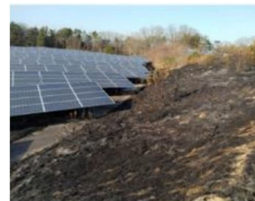
現場焼損状況
