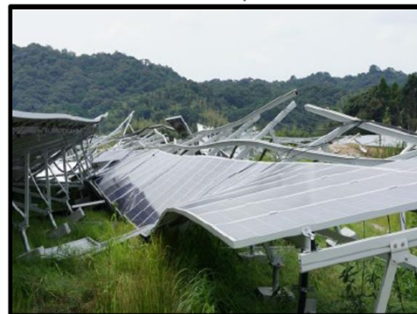
【九州 台風15号被害 (250kW)】(平成27年8月)
