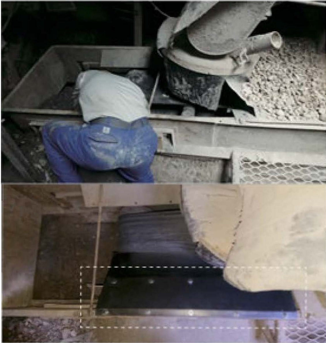
対策1:ベルトコンベアカバー設置
