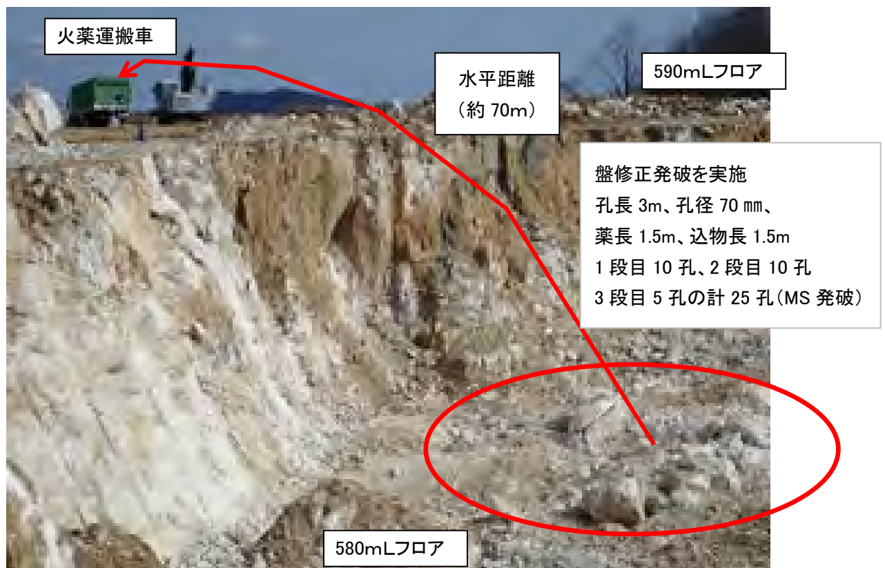
写真 2 発破箇所と飛石箇所
