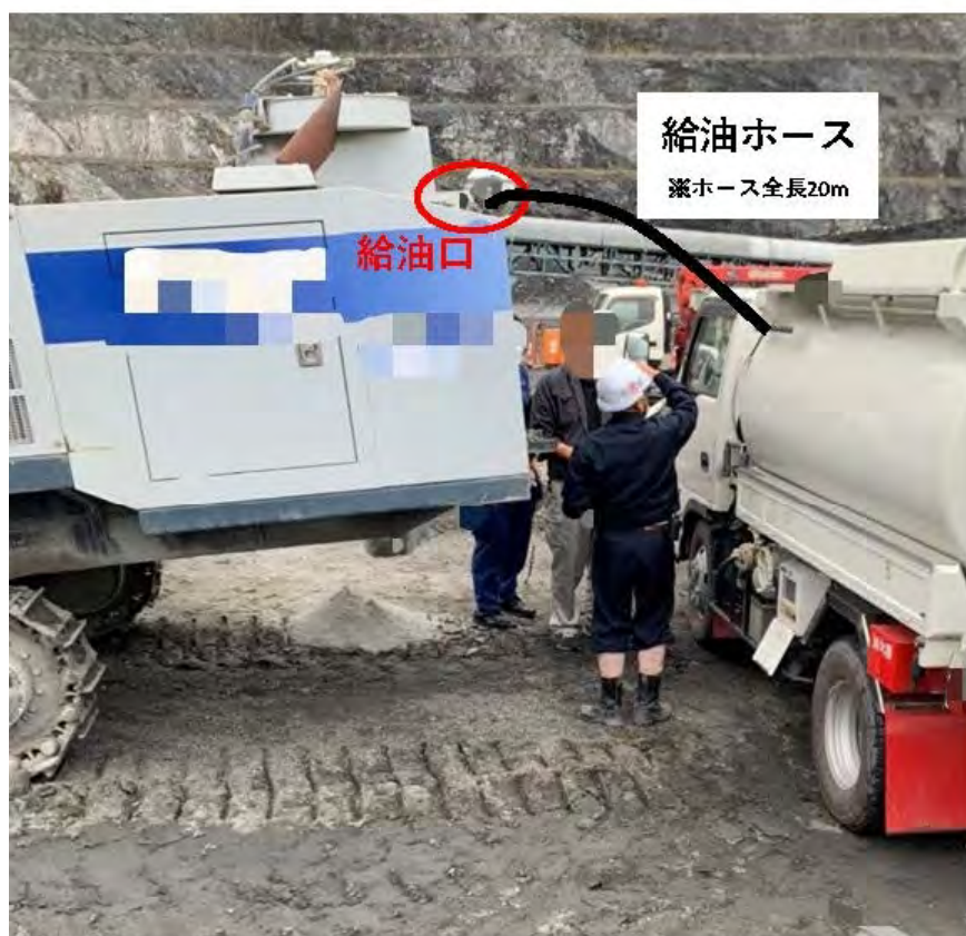
写真1 給油時のクローラードリルと給油タンクローリー車の配置
