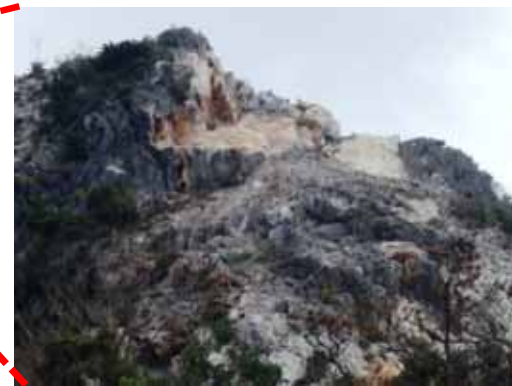
崩壊箇所(危険除去作業前) (平成29年2月2日撮影)
