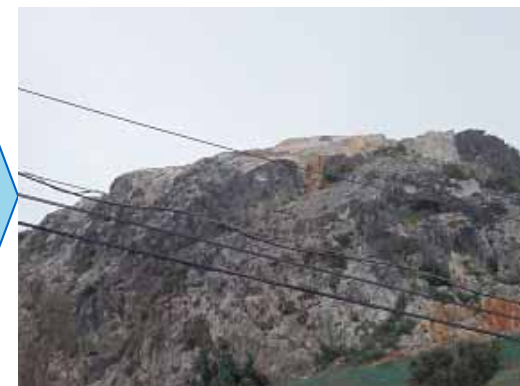
崩壊箇所(危険除去作業後) (平成30年2月5日撮影)
