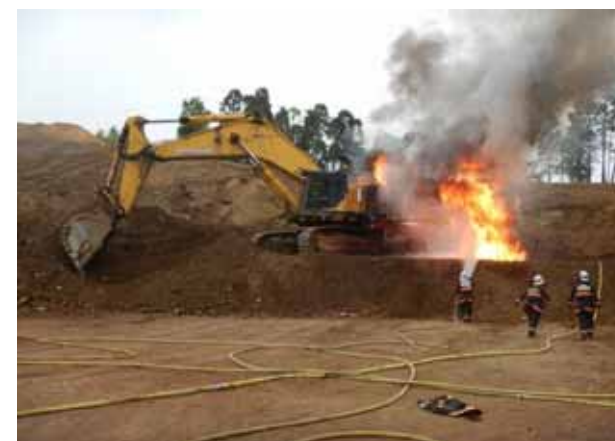
29年5月の火災現場
