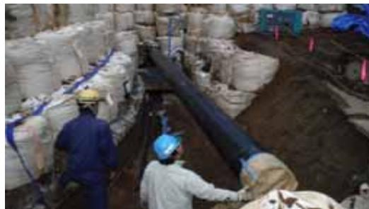
底設暗渠排水管設置(施工中)
