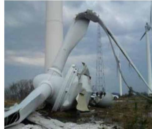
強風により損壊した風力発電設備
