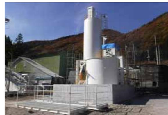
写真3 粉末石灰受入供給施設(H30年度より本格稼働予定)
